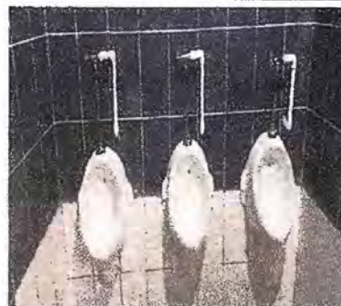
Foto 2: MODULO 1: Sustitucion de mingitorios e instalacion de accesorios
