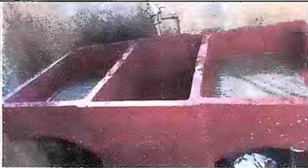
Foto 27: MODULO 8: Sustitucion e instalacion de Pila de dos lavaderos
