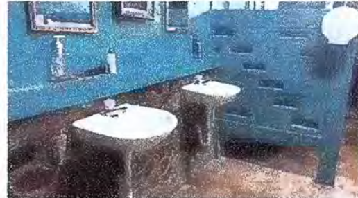
Foto 12: MODULO 2. Sustitucion de lavamanos e Instalacion de accesorios
