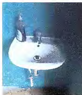
Foto 14: MODULO 3 Sustitucion de lavamanos e Instalacion de accesorios
