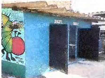
Foto 15: MODULO 3 Repacacion de puertas de sanitarios
