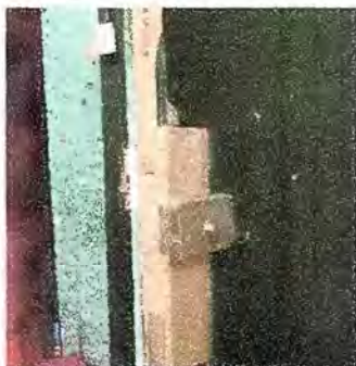
Foto19: MODULO 4 Sustitucion de Chapas y Mantenimiento de puertas.
