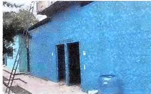
Foto 32: PINTURA GENERAL: Pintura en Muros Exteriores e interiores.
