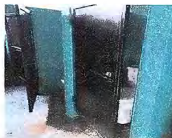
Foto 6: MODULO 1: Reparacion de puertas de sanitarios
