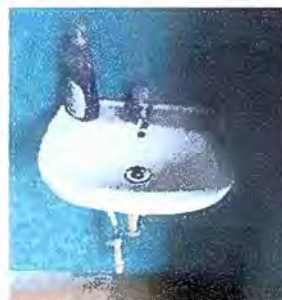
Foto 16: MODULO 3 Sustitucion de lavamanos e Instalacion de accesorios
