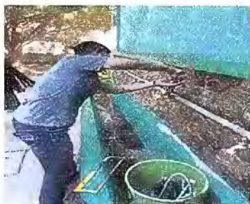
Foto 25: MODULO 6: Sustitucion de llave de chorro e instalacion de chorros
