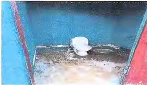
Foto 13: MODULO 3 Sustitucion de Sanitario e Instalacion de accesorios
