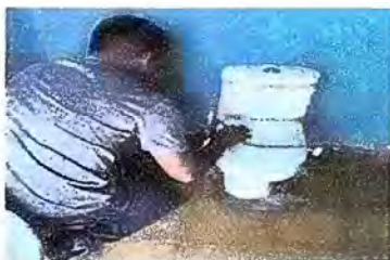
Foto3: MODULO 1: Sustitucion de inodoro e intalacion de accesorios
