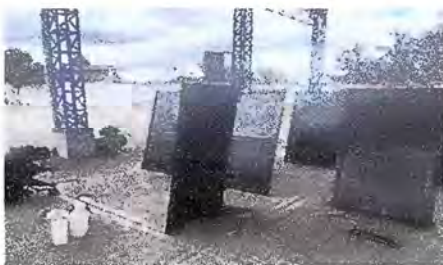
Foto 15: MODULO 3 Repacacion de puertas de sanitarios
