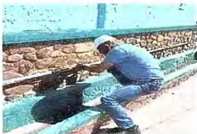
Foto 21: MODULO 4: Sustitucion de llave de chorro e instalacion de chorros
