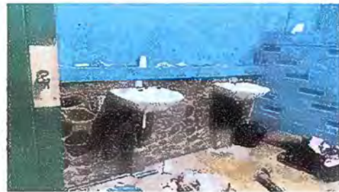
Foto 14: MODULO 3 Sustitucion de lavamanos e Instalacion de accesorios
