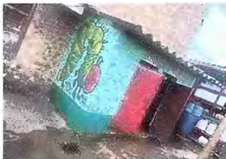
Foto 31: PINTURA GENERAL: Pintura en Muros Exteriores e interiores.
