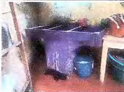
Foto 27: MODULO 8: Sustitucion e instalacion de Pila de dos lavaderos
