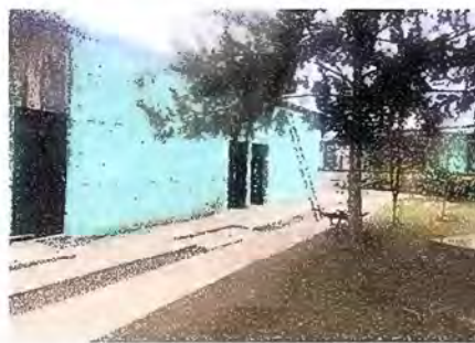
Foto 32: PINTURA GENERAL: Pintura en Muros Exteriores e interiores.
