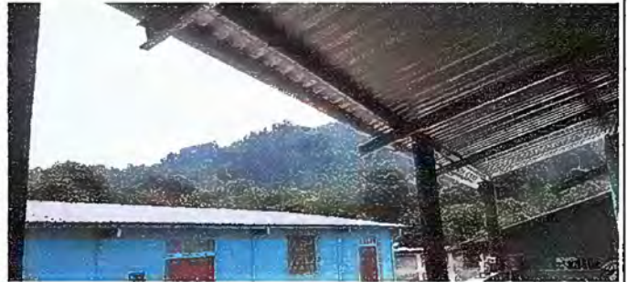
Foto 2: MODULO 1: SUSTITUCION DE ESTRUCTURA DE SOPORTE DE MADERA, POR METAL
