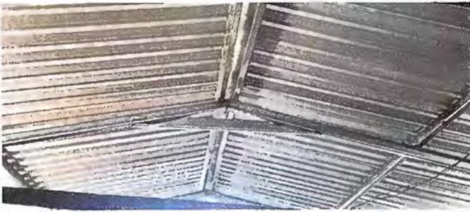
Foto 1: MODULO 1: SUSTITUCIÓN DE LAMINA, POR LÁMINA TROQUELADA ALUZINC CAL 26
