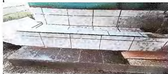
Foto 6: MODULO 1: SUSTITUCION DE AZULEJO
