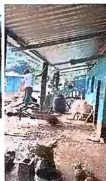
Foto 1 : MODULO 1 : SUSTITUCIÓN DE LÁMINA, POR LÁMINA TROQUELADA ALUZINC CAL 26
