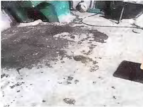
FOTO: 5 Módulo 1: Sustitución de piso cerámico
