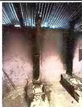
FOTO: 11 Módulo 1: Sustitución de estufa rural (completa) incluye Chimenea y plancha de metal
