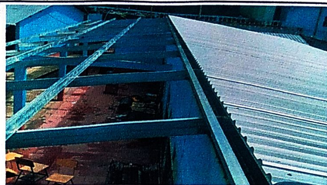
Foto 2: Modulo 1 Sustitución de estructura de soporte de madera por metal
