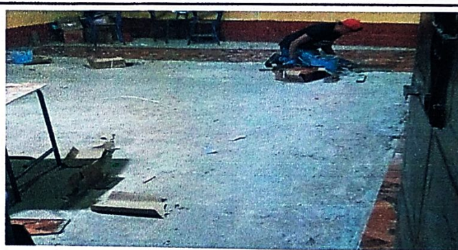
Foto 1: Módulo 2 y 3 sustitución de piso de concreto por piso ceramico
