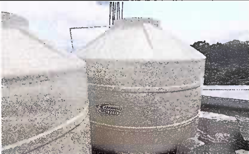
Foto 5: Sustrucción de depósito de agua
