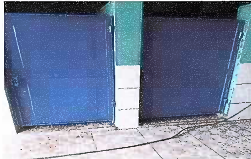
Foto 2: Instalación de puertas de metal en baños
