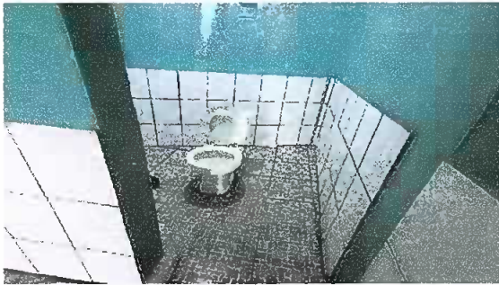
Foto 1: Sustrucción de inodoro
