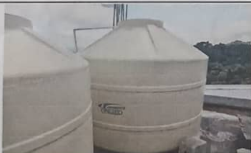
Foto 5: Módulo 2. Sustitución de depósito de agua
