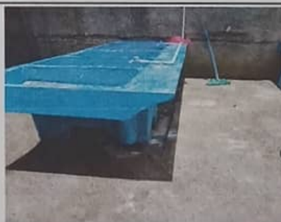
Foto 6: Módulo 2. Instalación de pilas
