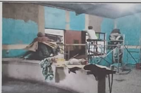
Foto 3: Módulo 1. Pintura en interiores y exteriores
