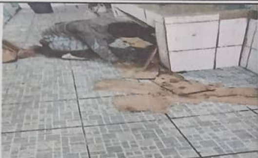
Foto 1: Módulo 1. Sustitución de piso de concreto por piso cerámico
