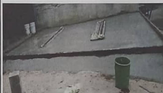
Foto 4: Módulo 2. Reparación de placa de concreto de patio
