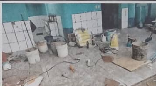
Foto 2: Módulo 1. Suministro e instalación de azulejo
