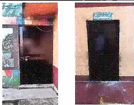
Foto 3: Módulo 2: Realización de sustitución de puertas
