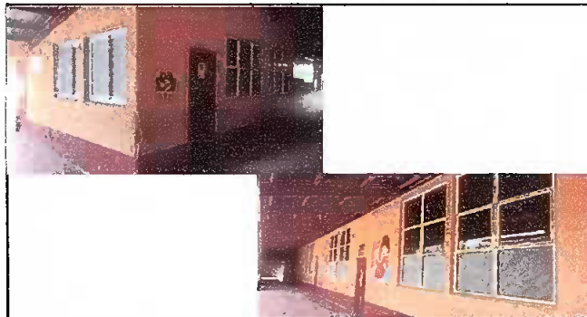
Foto 2: Módulos 2: Sustitución de estructura de metal de ventana
