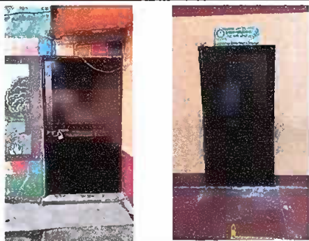
Foto 3: Módulo 2: Realización de sustitución de puertas
