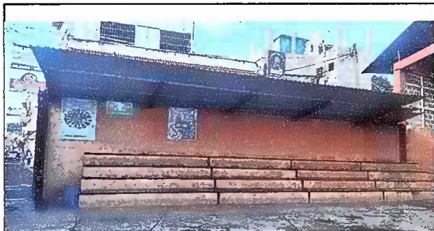
Foto1: Módulo 1: Realización de la sustitución de lámina por lámina troquelada aluzinc calibre 26
