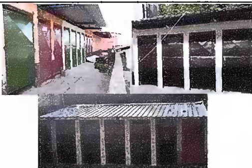
Foto 5: Módulo 3: Realización de sustitución de puerta en servicios sanitarios y sustitución de lámina existente por lámina troquelada aluzinc calibre 26
