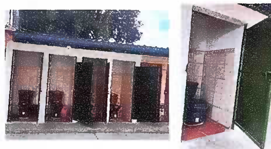
Foto 4: Módulo 3: Realización de repello de pared. Sustitución de inodoros
