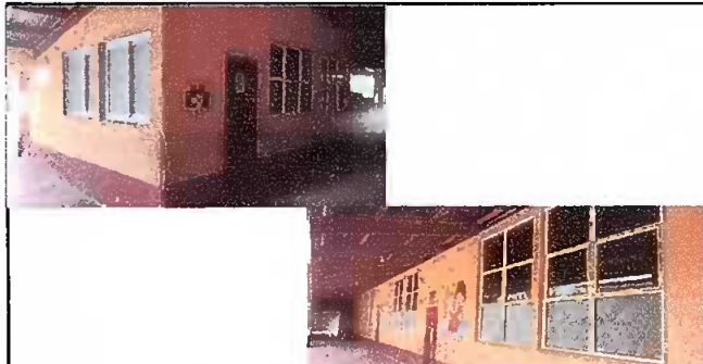
Foto 2: Módulos 2: Sustitución de estructura de metal de ventana
