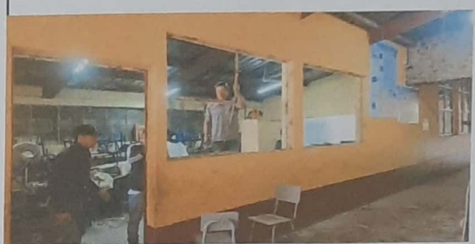
Foto 2: Módulos 2: Desinstalación de estructura de metal de ventana
