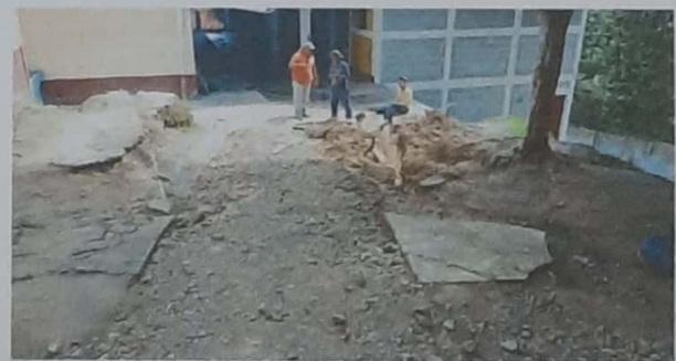
Foto 6: Módulo 4: Sustitución de tubería PVC para aguas negras y Sustitución de piso de torta de concreto.
