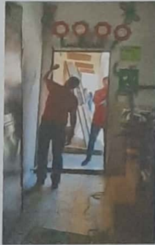
Foto 3: Módulo 2: Sustitución de puertas
