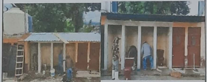
Foto 4: Módulo 3: Repello de pared. Sustitución de inodoros
