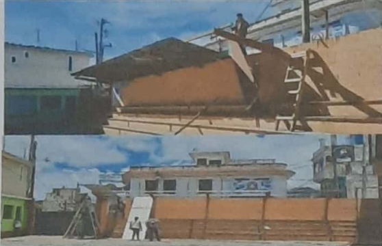
Foto 1: Módulo 1: Desinstalación de las láminas existentes. Instalación de lámina troquelada.
