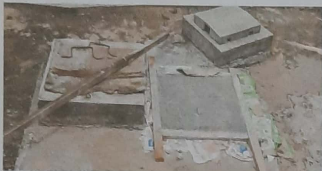
Foto 1: Áreas Exteriores. Sustitución de tapadera de concreto de cisterna subterráneo.
