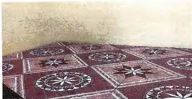
Modulo 1: Sustitución de piso cerámico.
