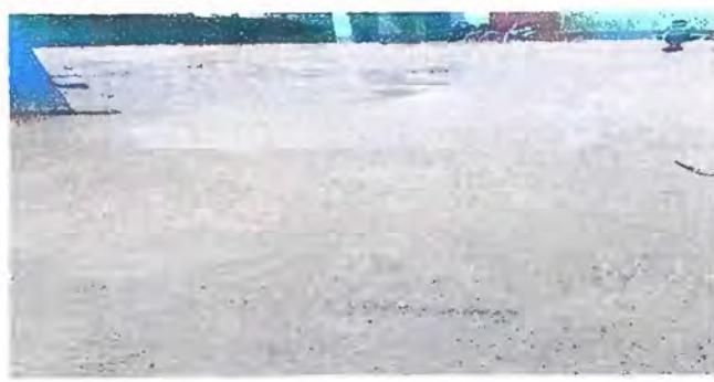
Patio: Reparación de planchas de concreto.
