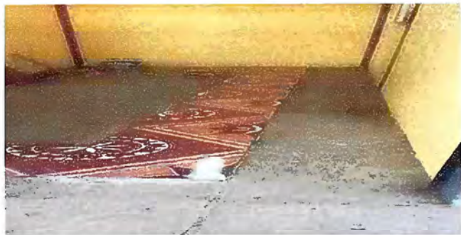
Modulo 1: Sustitución de piso ceramico
