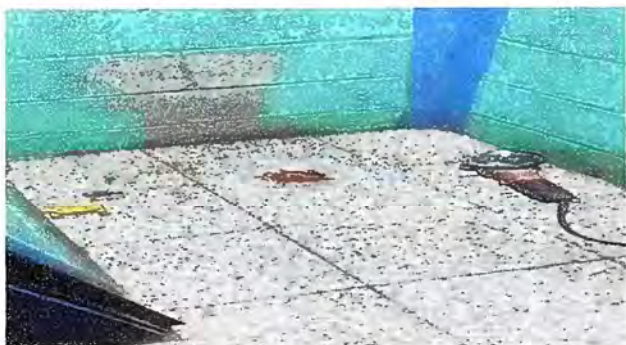
Modulo 2: Sustitucion de inodoro
