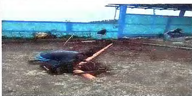
Patio: Sustitucion de tuberia PVC línea principal de aguas negras
