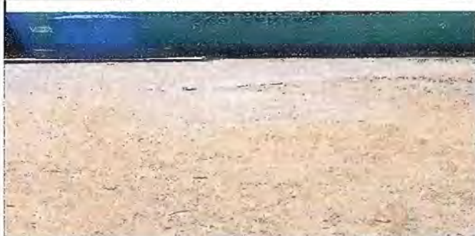
Modulo 3: Instalacion de tuberia para aguas negras
