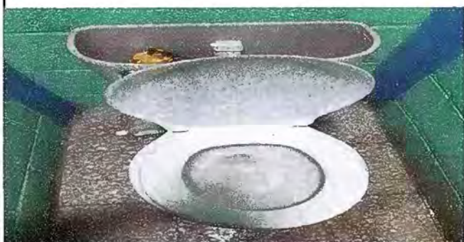
Modulo 2: Sustitucion inodoro
