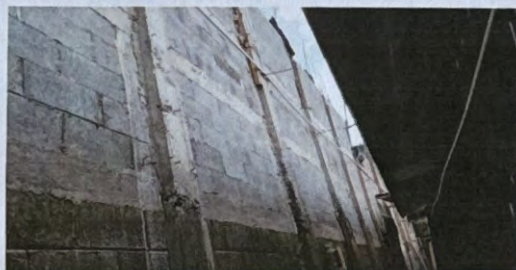
Foto 3: REPARACIÓN MURO DE CONTENCIÓN
