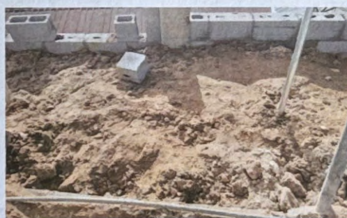
Foto 6: REPARACIÓN MURO DE CONTENCIÓN
