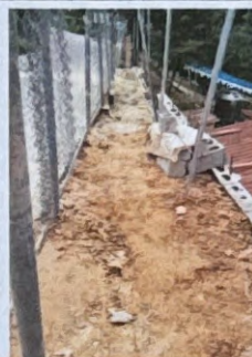
Foto 2: REPARACIÓN MURO DE CONTENCIÓN
