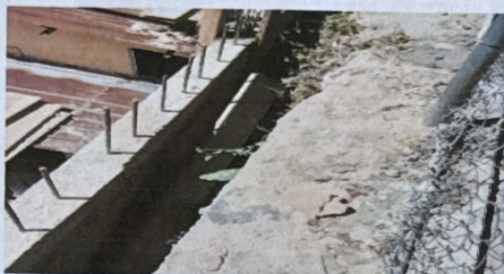
Foto 1: REPARACIÓN MURO DE CONTENCIÓN
