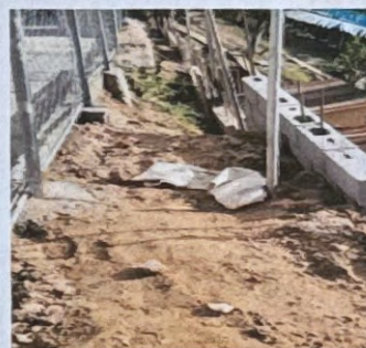
Foto 4: REPARACIÓN MURO DE CONTENCIÓN
