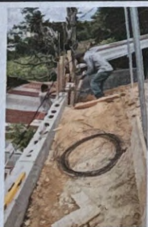
Foto 5: REPARACIÓN MURO DE CONTENCIÓN
