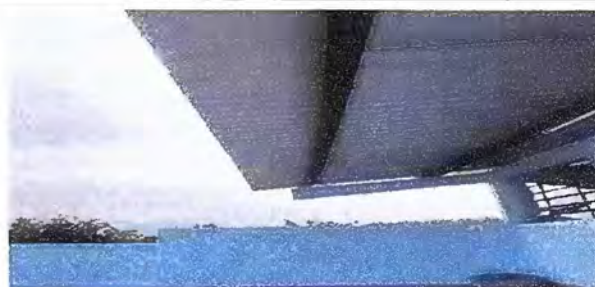
Foto 12: (MODULO IV: Sustitución de lámina por lámina troquelada
