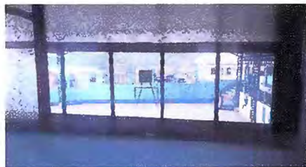
Foto13: (MODULO V) Sustitución de vidrios
