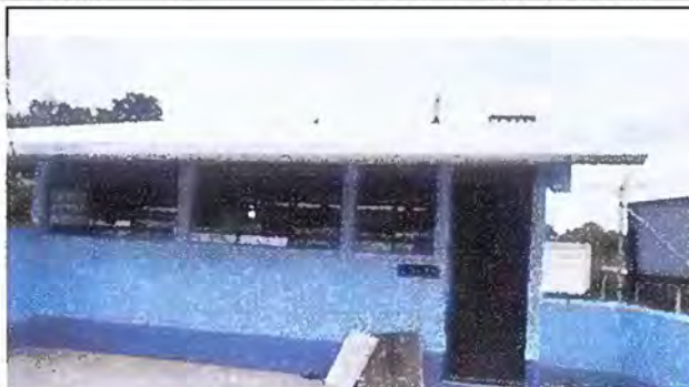
Foto 8: (MODULO III) sustitución de lámina por lámina troquelada
