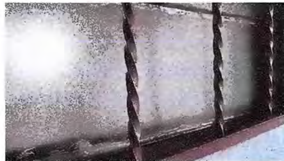
Foto 2: (MODULO I) Sustitución de vidrios
