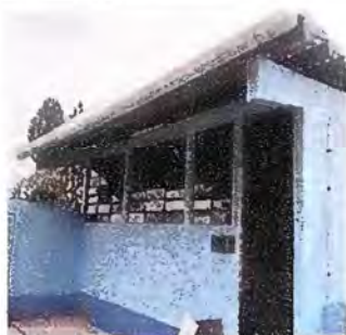
Foto 9: (MODULO IV) Mantenimiento a estructuras de puertas
