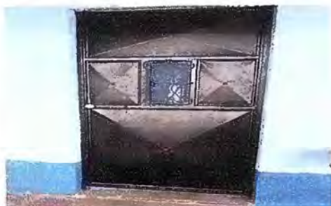
Foto 1: (MODULO I) Mantenimiento a estructuras de puertas
