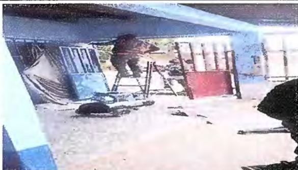
Foto 15: (MODULO V) Mantenimiento a estructuras de puertas
