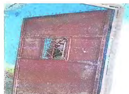
Foto 6: (MODULO III) Mantenimiento a estructuras de puertas
