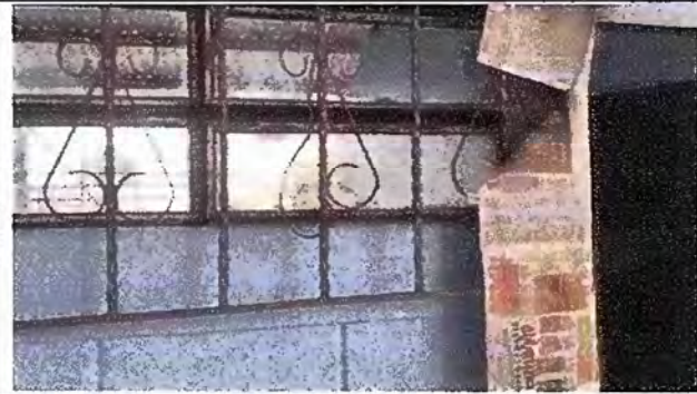
Foto 4: (MODULO II) Sustitución de vidrios
