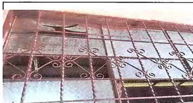
Foto 10: (MODULO IV) Sustitución de vidrios
