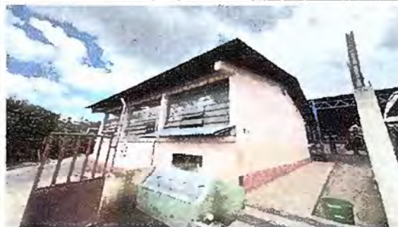
Foto 2: (MODULO I) Sustitución de vidrios
