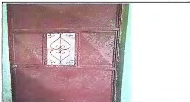
Foto 9: (MODULO IV) Mantenimiento a estructuras de puertas
