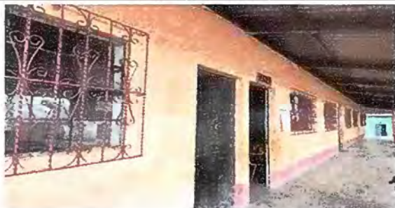
Foto 3: (MODULO II) Mantenimiento a estructuras de puertas
