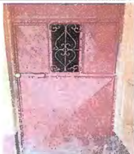
Foto 15: (MODULO V) Mantenimiento a estructuras de puertas
