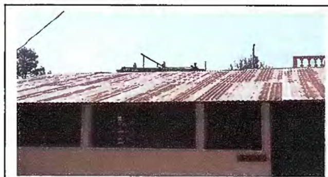
Foto 12: (MODULO IV) Sustitución de lámina por lámina troquelada
