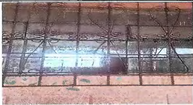
Foto13: (MODULO V) Sustitución de vidrios
