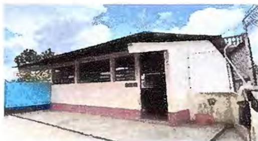
Foto 5: (MODULO III) Suministro e instalación de canal
