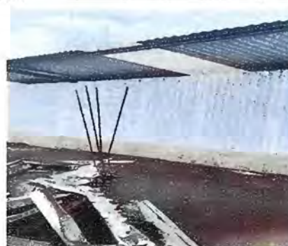
Foto No. 10 MODULO 5 Sustitución de láminas por láminas traslucida policarbonato
