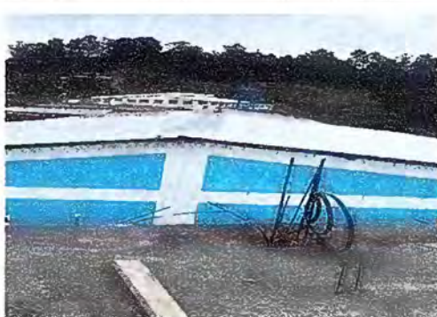
Foto No. 1 MODULOS 1 Sustitución de lámina por lamina toquelada aluzinc calibre 26 y mantenimiento a estructura de soporte metal
