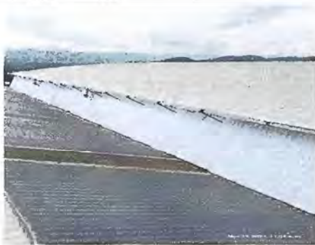
Foto No. 9 MODULO 5 Sustitución de canal de metal y sustitución de soporte de metal para canal.
