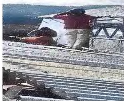
Foto No. 10 MODULO 5 Sustitución de láminas por láminas traslucida policarbonato
