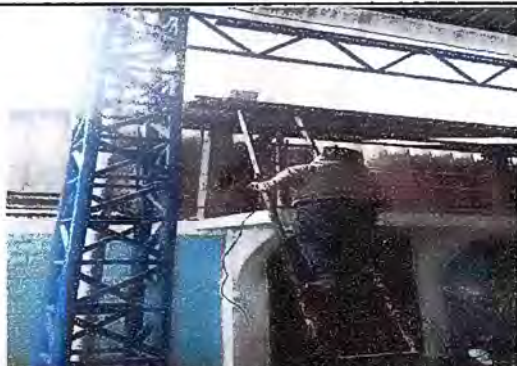
Foto No. 9 MODULO 5 Sustitución de canal de metal y sustitución de soporte de metal para canal.
