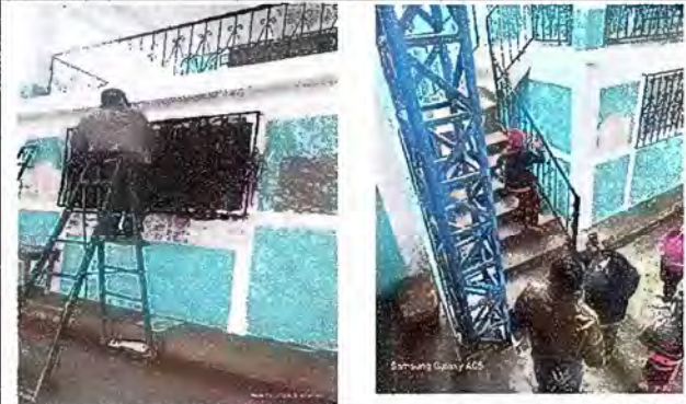
Foto No. 4 MODULOS 2 Mantenimiento de balcones de metal, sustitución de puertas y mantenimiento a estructura de puertas (aplicación de pintura)
