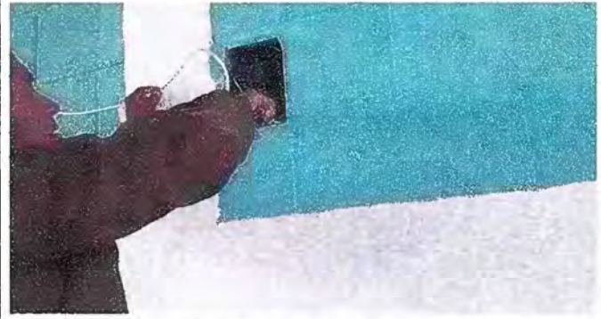
Foto No. 2 MODULO 1 Sustición de flípones, sustitución de focos ahorradores y sustitución de ducto eléctrico + accesorio.
