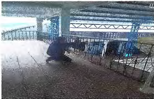
Foto No. 5 MODULO 2 Mantenimiento a baradas de metal.
