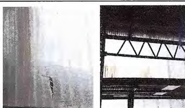
Foto No. 10 MODULO 5 Sustrucción de láminas por láminas traslúcidas policarbonato
