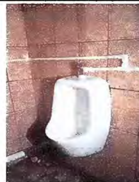
Foto 22 Módulo 5: Sustitución de migitorio.
