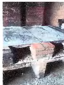
Foto 16 Módulo 3: sustitución de plancha de metal de tres hornillas
