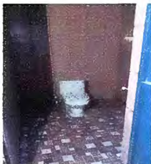
Foto 21 Módulo 5: Sustitución de inodoro.
