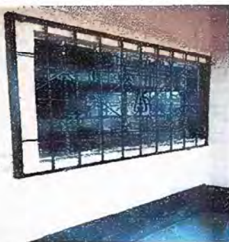
Foto 11 Módulo 2: Sustitución de balcón de metal.
