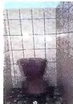
Foto 26 Módulo 6: Sustrucción de inodoro.
