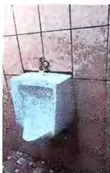
Foto 27 Módulo 6: Sustrucción de mingitorio.
