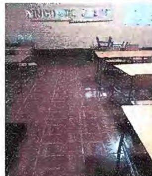
Foto 12 Módulo 3: Sustitución de piso de torta de concreto por piso cerámico.
