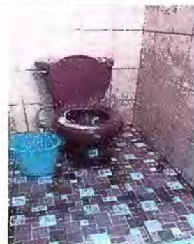
Foto 28 Módulo 6: Sustrucción de llaves de paso.
