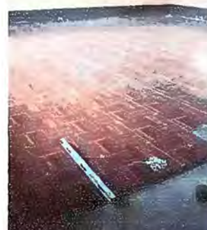
Foto 12 Modulo 3: Sustitución de piso de torta de concreto por piso ceramico.
