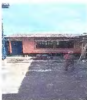
Foto 15 Modulo 3: Sustitución de lamina por lámina Troquelada Aluzinc
