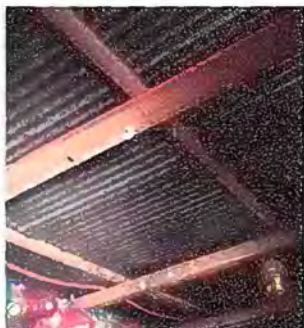
Foto 7. Modulo 1: Sustitucion de ducto Eléctrico
