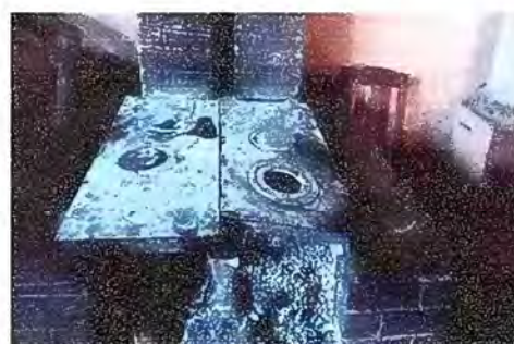
Foto 16 Modulo 3: sustitución de plancha de metal de tres ornillas
