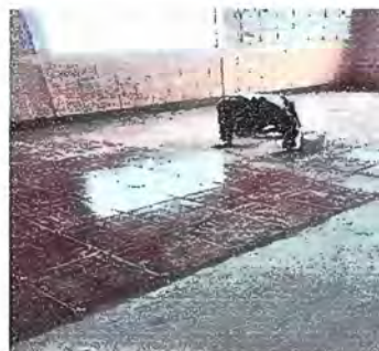
Foto 18 Modulo 4: Sustitución de piso de torta de concreto por piso cerámico.
