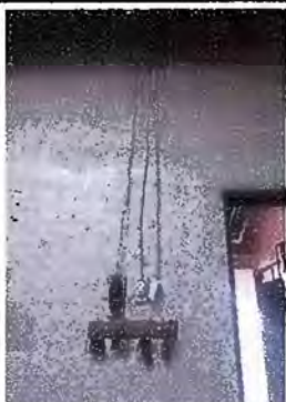
Foto 5. Módulo 1: Reparación de cableado eléctrico.
