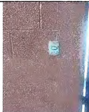
Foto 4. Módulo 1: Sustrucción de interruptores simples.
