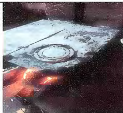
Foto 16 Módulo 3: sustitución de plancha de metal de tres hornillas
