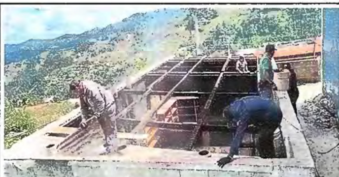
Foto 5: Modulo II. Sustitución de estructura de soporte de madera por metal
