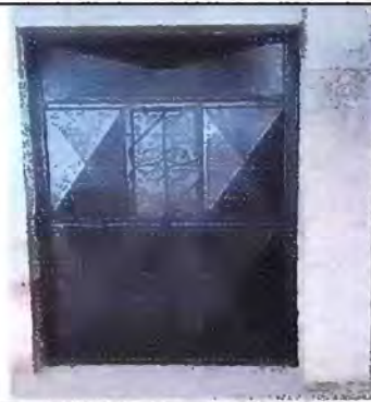
Foto 10: Modulo VI. Sustitución de puerta de aula
