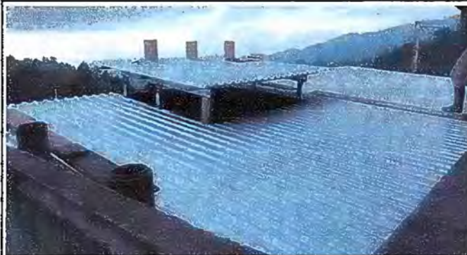
Foto 4: Modulo II. Sustitución de lámina por lámina Traquelada Aluzinc Calibre 26
