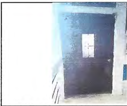
Foto 11: Modulo VI. Sustitución de puerta de aula
