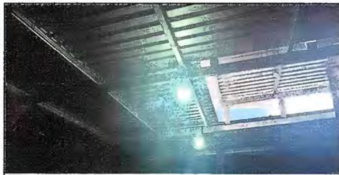
Foto 6: Modulo II. Sustitución de estructura de soporte de madera por metal
