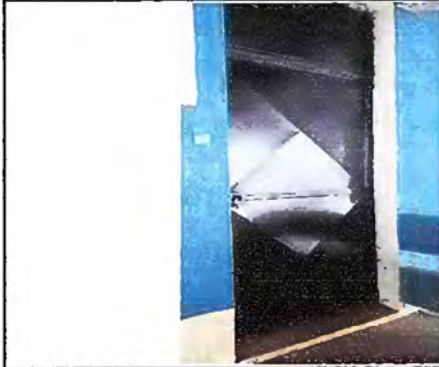
Foto 7: Modulo III. Sustitución de puerta de baño de niños
