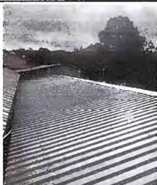
Foto 3: Modulo I. Sustitución de elementos de fijación (tornillos)
