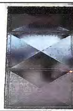
Foto 12: Modulo V. Sustitución de puerta de aula
