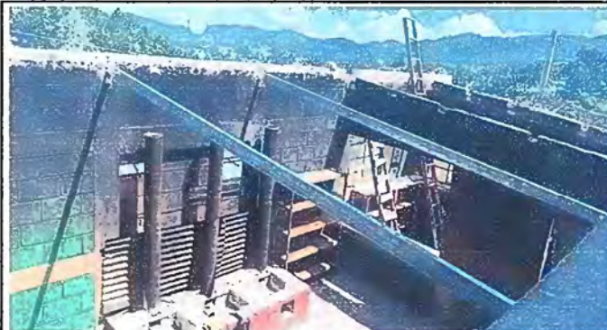
Foto 4: Módulo 2. Techo de Cocina. Instalación de soporte de láminas de metal
