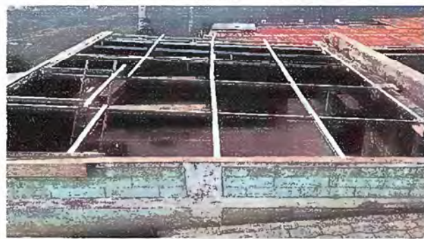
Foto 6: Módulo 2. Techo de cocina. Instalación completa de soporte de láminas
