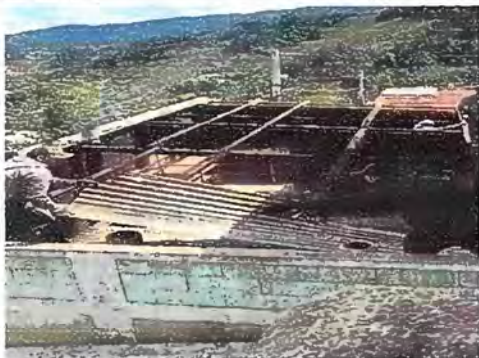
Foto 1: Módulo 2. Techo de cocina. Sustitución de láminas existente
