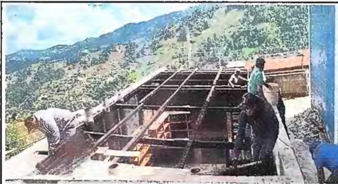
Foto 2: Módulo 2. Techo de cocina. Sustitución de láminas y soporte de madera existente
