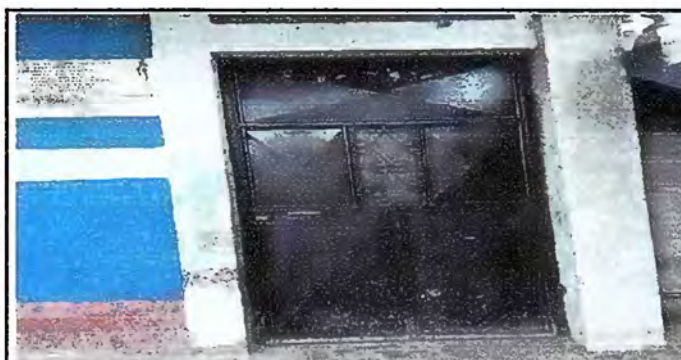
Foto 5: Módulo IV. Sustitución de puerta
