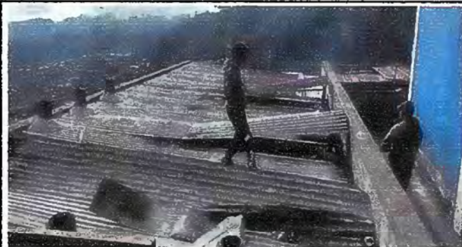
Foto 2: Módulo II. Sustitución de láminas por láminas traquelada aluzinc calibre 26
