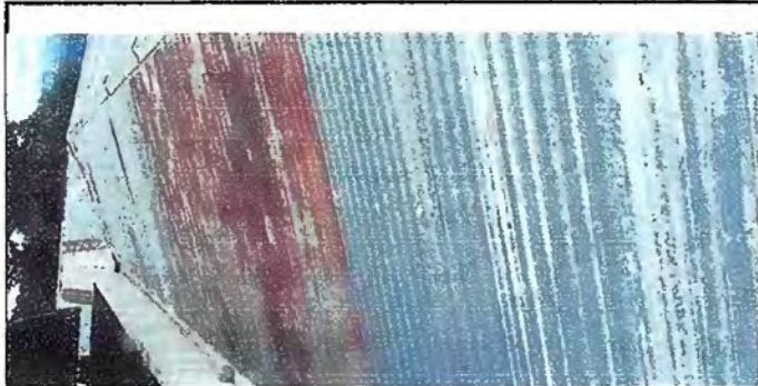
Foto 1: Módulo I. Sustitución de láminas por láminas traquelada aluzinc calibre 26
