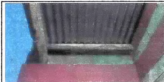
Foto 3: Módulo II. Sustitución de estructura de soporte de madera, por metal
