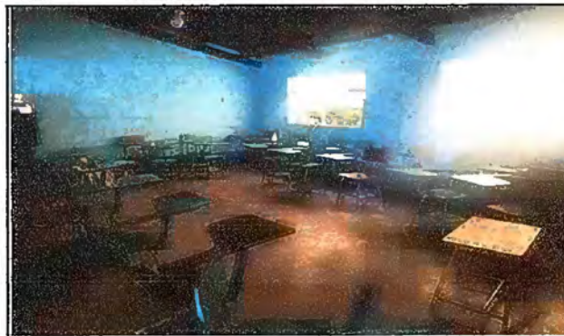
Foto 2: Pintura de interiores modulo 1
