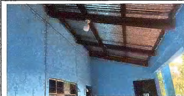
Foto 3: sustitucion de focos ahorradores modulo 1
