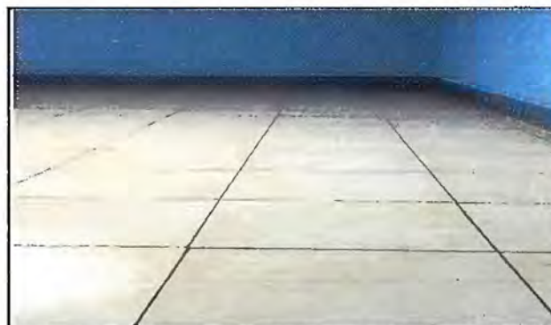
Foto 6: sustitucion de torta de piso de concreto por piso ceramico modulo 4
