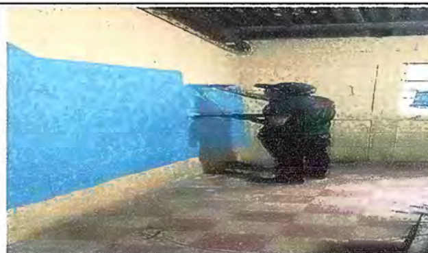
Foto 4: pintura de interiores y exteriores modulo 2
