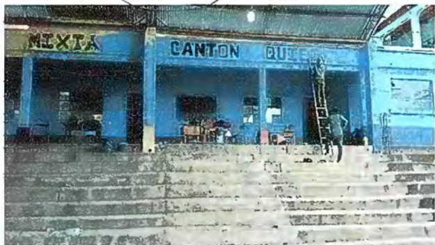
Foto1: pintura de interiores y exteriores modulo 1
