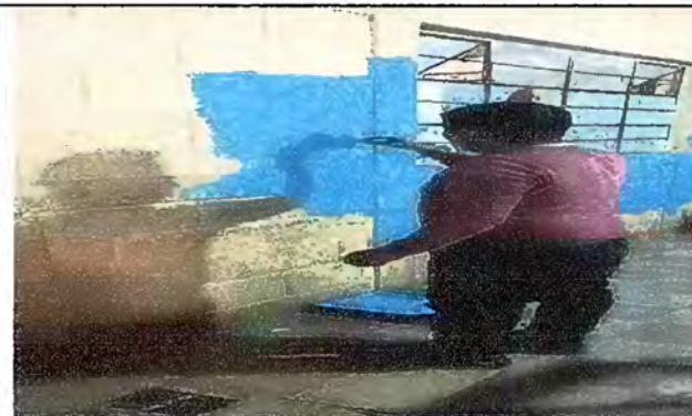
Foto 2: Pintura de interiores modulo 1
