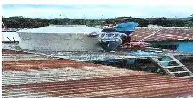
Foto 5: sustitucion de deposito de agua modulo 2
