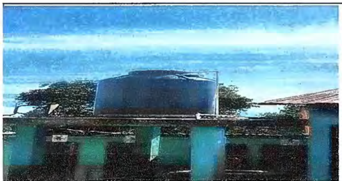
sustitucion de deposito de agua modulos 2
