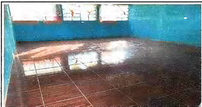
Foto 5: Modulo 3: Sustrucción de piso de concreto por piso de cerámico
