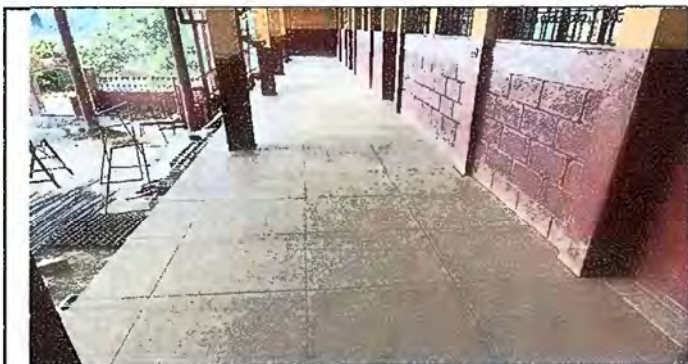
Foto 3: Módulo 2: Sustrucción de piso de concreto por piso de cerámico
