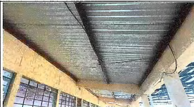
Foto2: Módulo 1: Mantenimiento a estructura de metal
