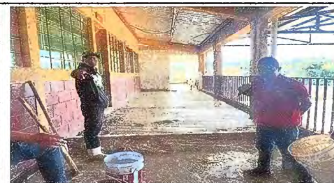
Foto 6: Módulo 3: Avance de Sustitución de piso de concreto
