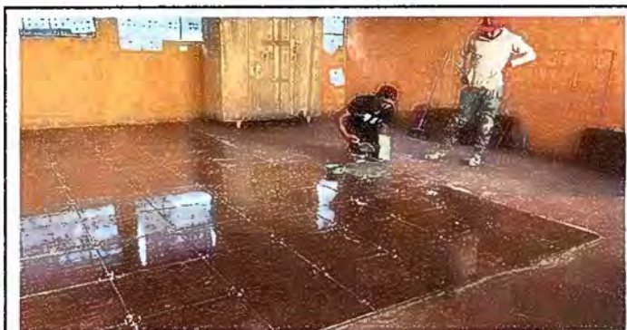
Foto 5: Módulo 3: arreglo de pared repellado
