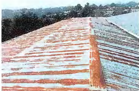
Foto1, módulo 1: Sustitución de tornillo, capote y lámina, por lámina troquelada aluzinc calibre 26
