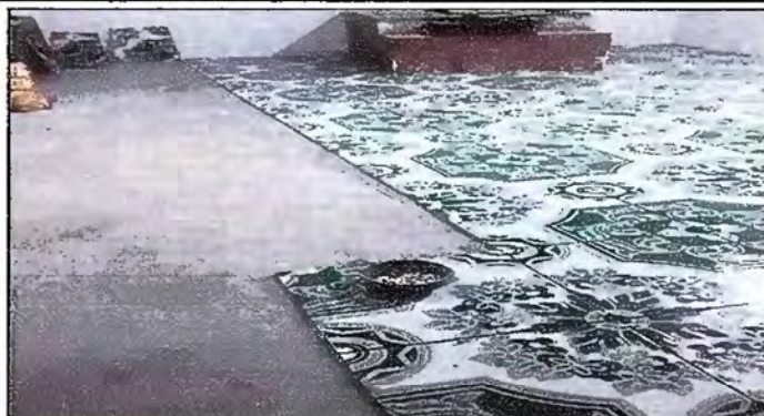
Foto 8: SUSTITUCION DE PISO DE TORTA DE CONCRETO EN COCINA Y EN BODEGA, EN MODULO 7
