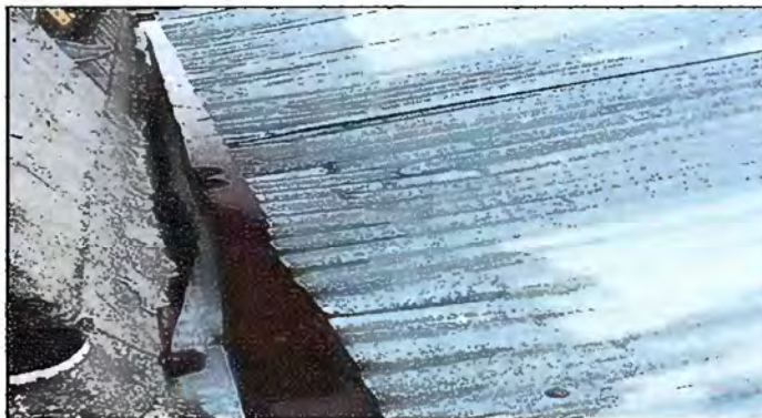
Foto 4: SUSTITUCION DE LAMINA POR LAMINA TROQUELADA EN MODULO 2.
