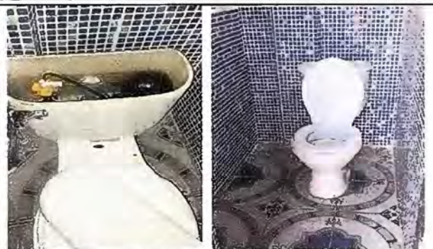
Foto 1, Módulo 1: sustitución de accesorios inodoro (contra llave, tubo de abasto y tanque)
