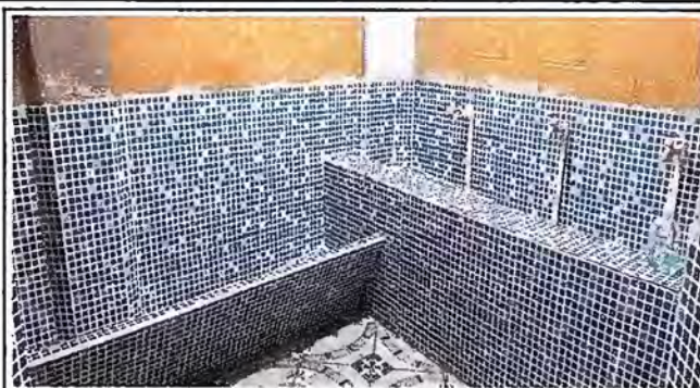
Foto 2, Módulo 1: Suministro e instalación de azulejos.
