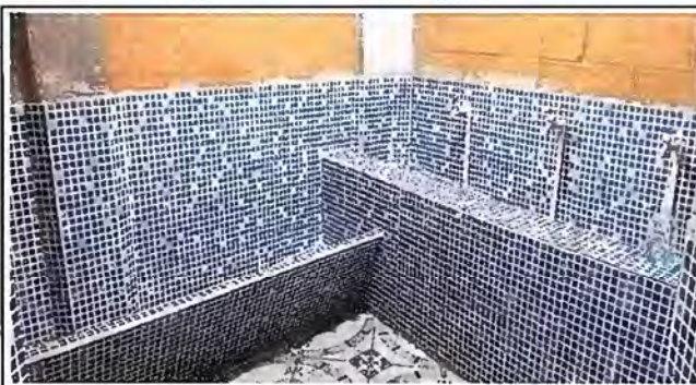
Foto 2, Módulo 1: Suministro e instalación de azulejos.
