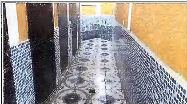
Foto 3, Módulo 1: Sustitución de piso de concreto por piso cerámico.
