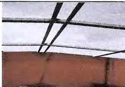
Foto 4, Módulo 2: Sustitución de lámina, por lámina troquelada aluzinc calibre 26 y Sustitución de estructura de soporte de madera, por metal.
