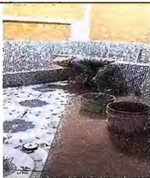
Foto 3, Módulo 1: Sustitución de piso de concreto por piso cerámico.
