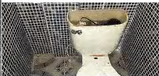
Foto 1, Módulo 1: sustitución de accesorios inodoro (contra llave, tubo de abasto y tanque)
