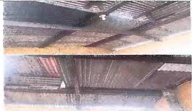
Foto 4, Módulo 2: Sustitución de lámina, por lámina troquelada aluzinc calibre 26 y Sustitución de estructura de soporte de madera, por metal.
