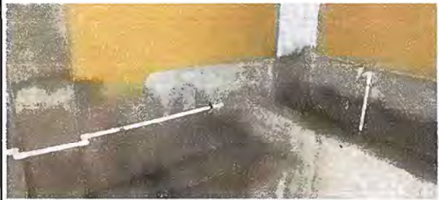
Foto 2, Módulo 1: Suministro e instalación de azulejos.
