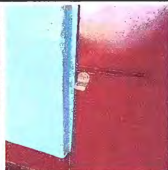
Foto 6: Módulo 2 Sustitución de chapas en puerta de metal.
