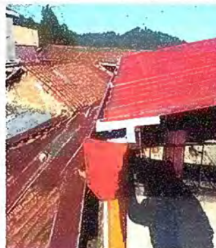
Foto 4: Módulo 1 Sustitución de canal de metal.
