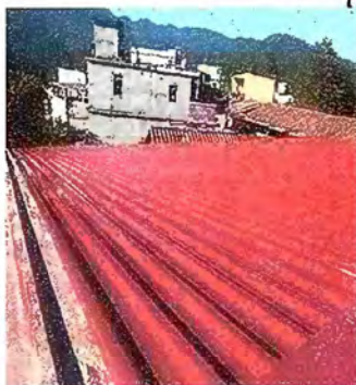
Foto1: Módulo 1 Sustitución de láminas troquelada calibre 26.
