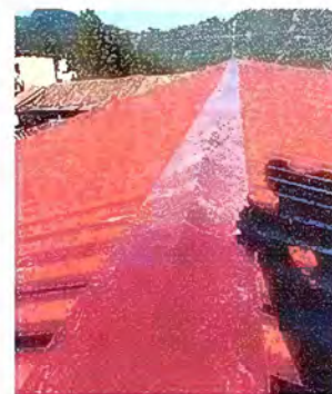
Foto 2: Módulo 1 Sustitución de capote para capote lámina troquelada alucinc
