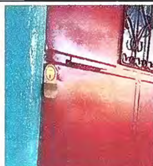
Foto 6: Módulo 2 Sustitución de chapas en puerta de metal.
