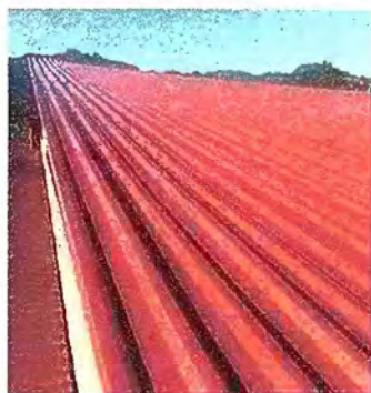
Foto1: Módulo 1 Sustitución de láminas troquelada calibre 26.
