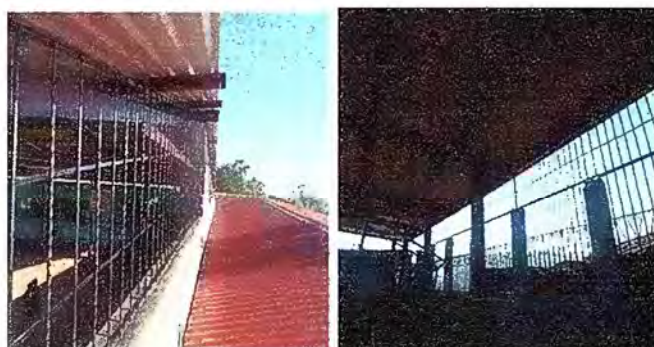
Foto 9: Muro perimetral. Reparacion de baranda perimetral.
