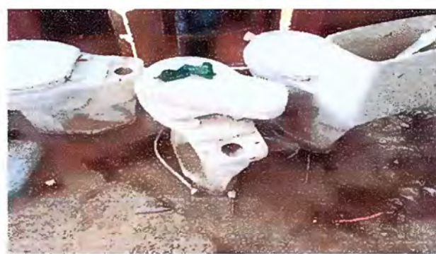
Foto 8: Módulo 4. Sustitución de inodoros
