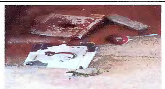
Foto 6: Módulo 2 Sustitución de chapas en puerta de metal.
