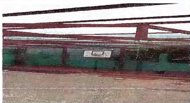
Foto 9: Muro perimetral. Reparacion de baranda perimetral.
