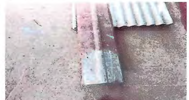
Foto 4: Módulo 1 Sustitución de canal de metal.
