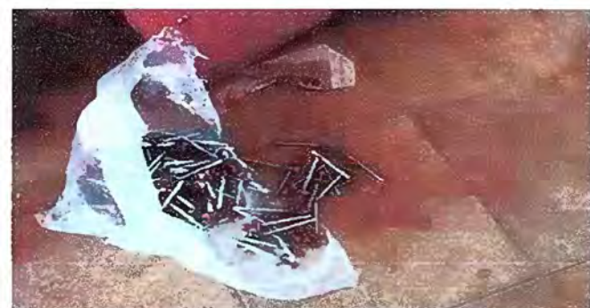
Foto 3: Módulo 1 Sustitución de elemento de fijación tornillo
