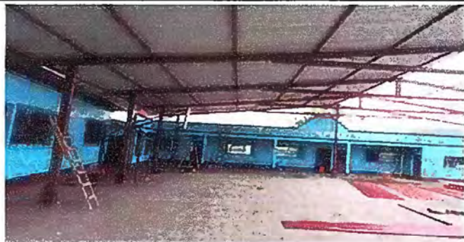
Foto 1: Módulo 1 Sustitución de láminas troquelada calibre 26.
