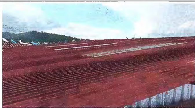
Foto 1: Módulo 1. Sustitución de lámina troquelada, calibre 26.
