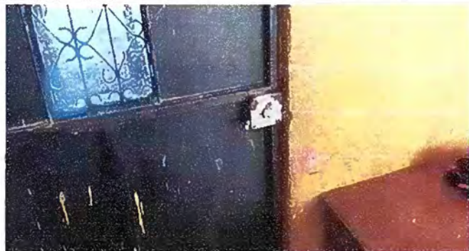
Foto 7: Módulo 3. Sustitución de chapas en puertas de metal
