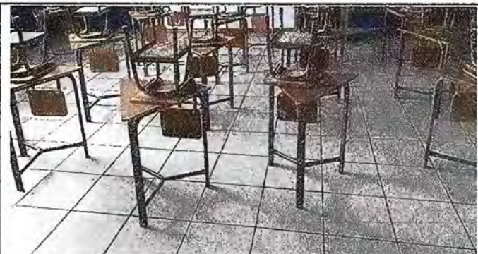
Foto 6: Sustrución de piso de torta de concreto por cerámico aula numero 2
