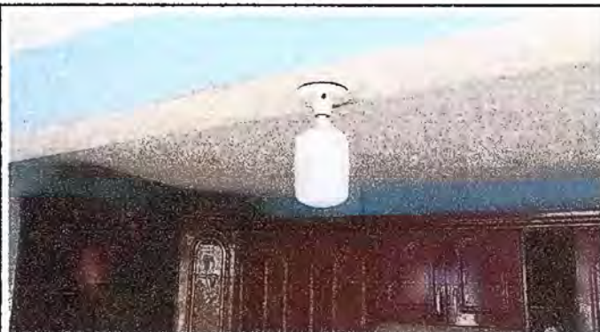
Foto 4: Sustrución de cableado de cocina
