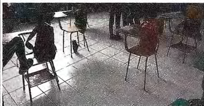
Foto 5: Sustrución de piso de torta de concreto por cerámico aula numero 1
