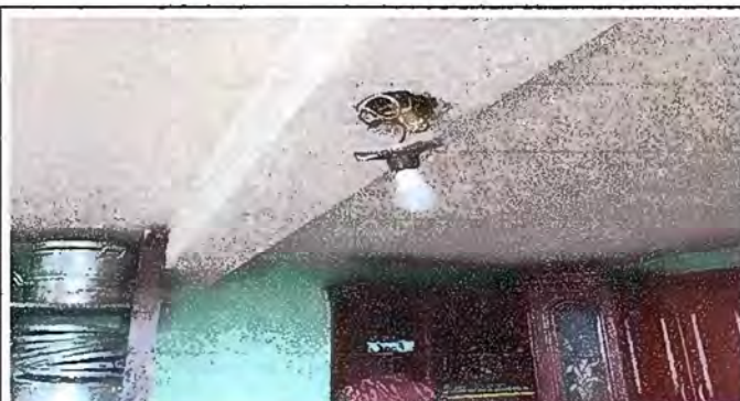
Foto 4: Sustitución de cableado de cocina
