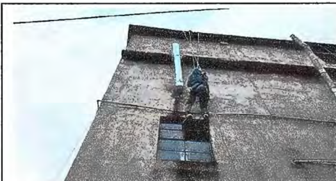
Foto 3: Sustitución de chimeneas de cocina numero 2
