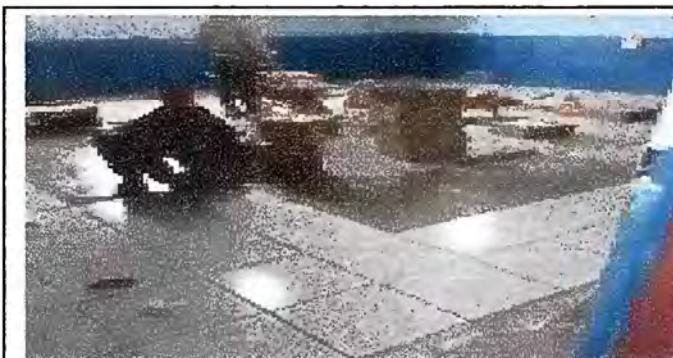
Foto 5: Sustitución de piso de torta de concreto por cerámico aula numero 1
