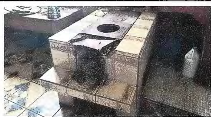
Foto 11: Sustrucción de plancha de cocina numero 1
