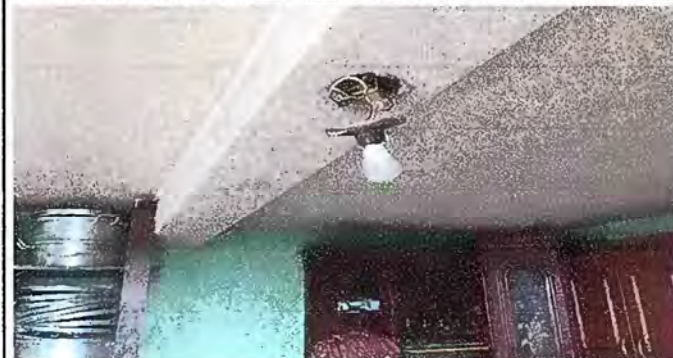
Foto 4: Sustitución de cableado de cocina
