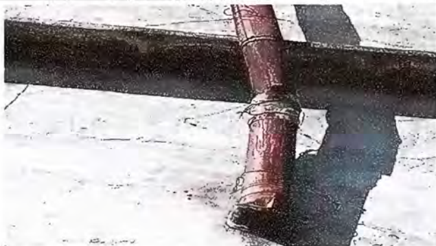
Foto 3: Sustitución de chimeneas de cocina numero 2
