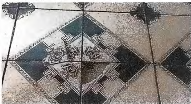
Foto1: Sustitucion de piso ceramico de cocina
