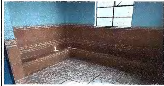
Foto 10: Sustrucción de migitorios por losa
