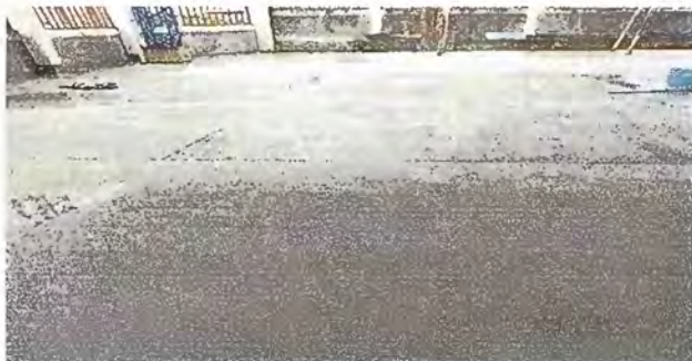
Foto 1: Reparación de plancha de concreto de patio
