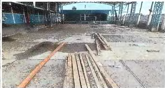
Foto 1: Reparación de plancha de concreto de patio
