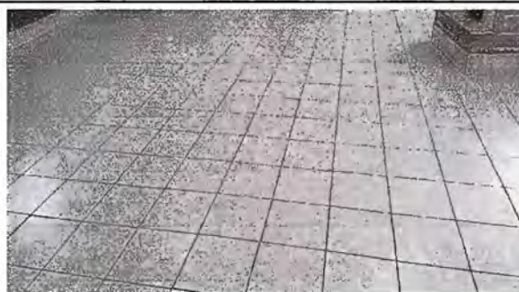
Foto 6: Sustitución de piso de cemento líquido a piso cerámico
