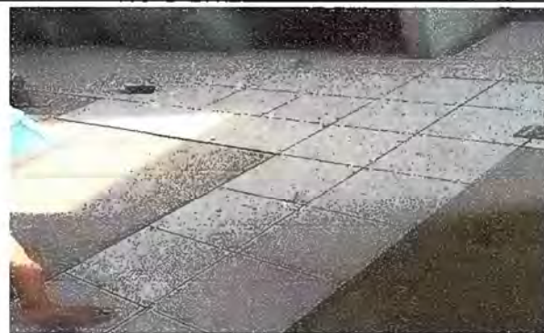
Foto 4: Sustitución de piso de cemento líquido a piso cerámico
