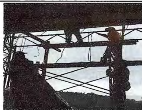
Foto 2: Sustitución de canal de metal
