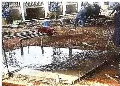
Foto 1: Reparación de plancha de concreto de patio
