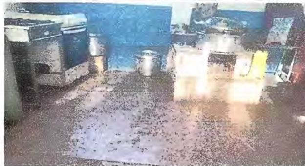
Foto 6: Sustitución de piso de cemento líquido por piso cerámico
