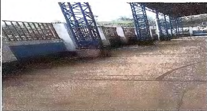
Foto 1: Reparación de plancha de concreto de patio
