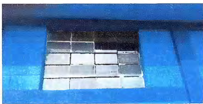
Foto 22: Modulo 6 sustitución de vidrio
