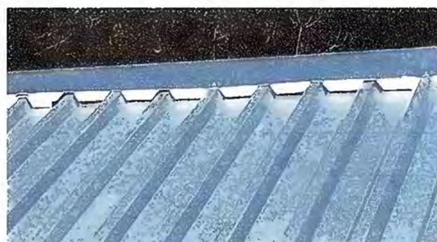
Foto 4: modulo 1 Sustitución de capote de lámina para lamina troquelada.
