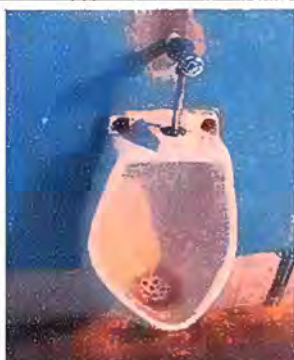
Foto 15: Modulo 5 sustrucion de llave de mingitorio.
