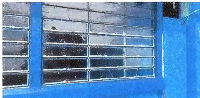
Foto 2: Modulo 1. Sustitución de vidrios.
