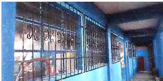
Foto 12: Módulo 4 Suministros e instalación de balcon de hierro en ventana.
