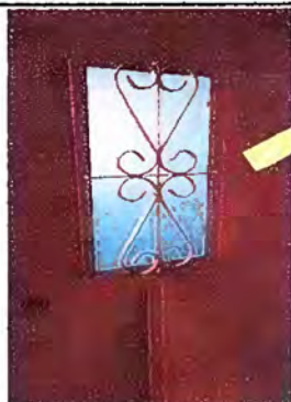
Foto 9: Módulo 3 sustitución de vidrio
