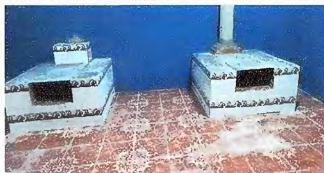
Foto 10: Módulo 3 Sustitución de estufa rural (completa) incluye chimenea y plancha de metal
