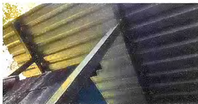
Foto 16: modulo 5. sustrucion de estructura de soporte de madera por metal.
