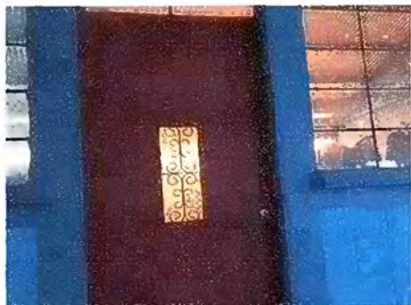
Foto 7: Módulo 2 Sustitución de vidrios
