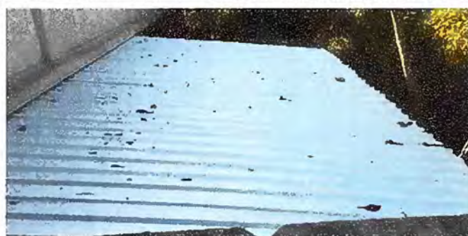
Foto 17: modulo 5. Sustrucion de lámina, por lámina troquelada calibre 26.
