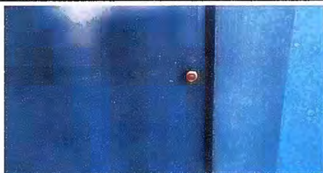
Foto 11: módulo 4 Sustitución de chapa
