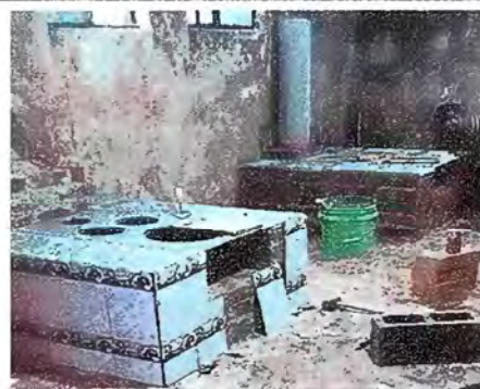
Foto 10: Modulo 3 Sustitucion de estufa rural (completa) incluye chimenea y plancha de metal
