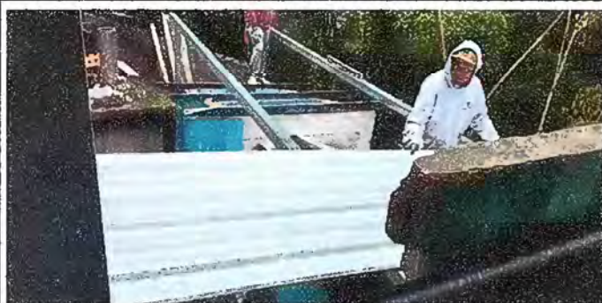
Foto 17: modulo 5. Sustitución de lámina, por lámina troquelada calibre 26.
