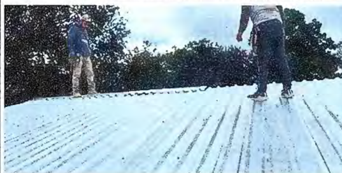
Foto 4: modulo 1 Sustitución de capote de lámina para lamina troquelada.
