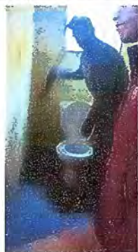
Foto13: Modulo 5. Sustitución de accesorios de inodoro (contra llave, tubo de abasto y tanque)
