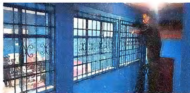
Foto 12: Modulo 4 Suministros e instalación de balcon de hierro en ventana.
