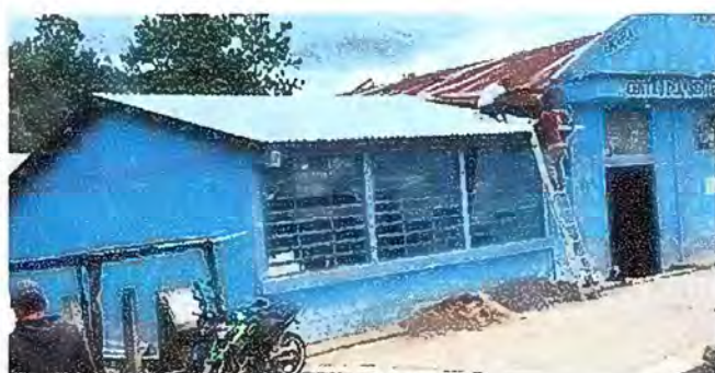
Foto 3: Modulo 1 Sustitución de elementos de fijación (tornillos)
