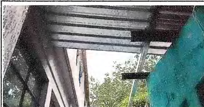
Foto 16: modulo 5. sustitución de estructura de soporte de madera por metal.
