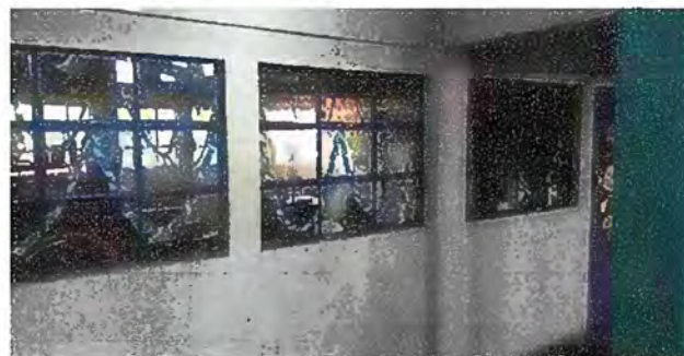
Foto 12: Modulo 4 Suministros e instalación de balcon de hierro en ventana.
