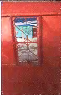
Foto 7: Modulo 2 Sustitución de vidrios
