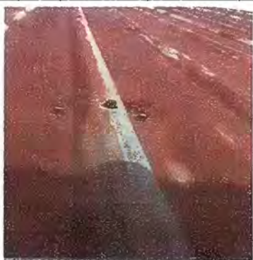
Foto 3: Modulo 1 Sustitución de elementos de fijación (tornillos)
