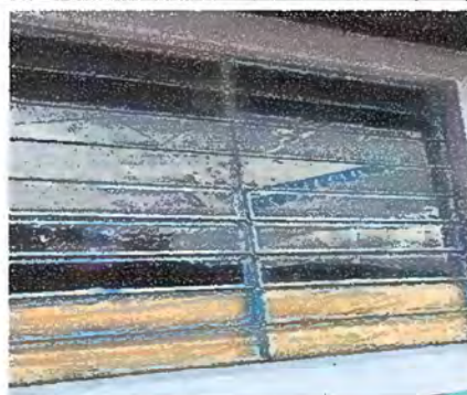
Foto 2: Modulo 1. Sustitución de vidrios.
