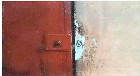
Foto 8: Modulo 3 Sustitucion de Chapa .
