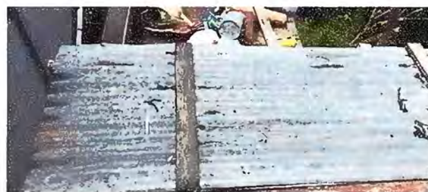
Foto 18: modulo 5. Sustitución de elementos de fijación (tornillos)
