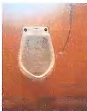
Foto 15: Modulo 5 sustitucion de llave de mingitorio.
