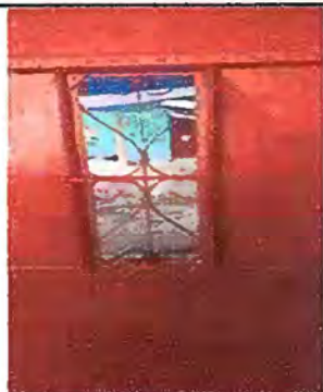
Foto 9: Modulo 3 sustitucion de vidrio
