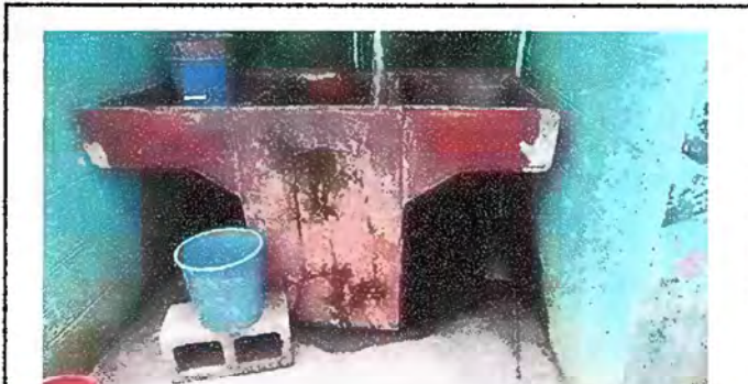
Foto 20: módulo 5. Sustrucción de pilas de cemento de dos lavadero
