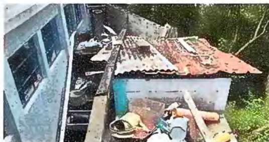
Foto 17: modulo 5. Sustitución de lámina, por lámina troquelada calibre 26.
