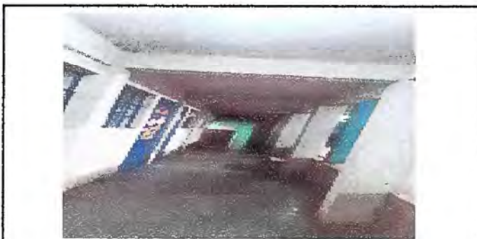
Foto 23: módulo 6 pintura general en muros exteriores e interiores.
