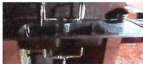
Foto 14: modulo 5. Sustitución de trastos
