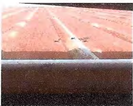
Foto 5: Modulo 1 sustitución de canal.
